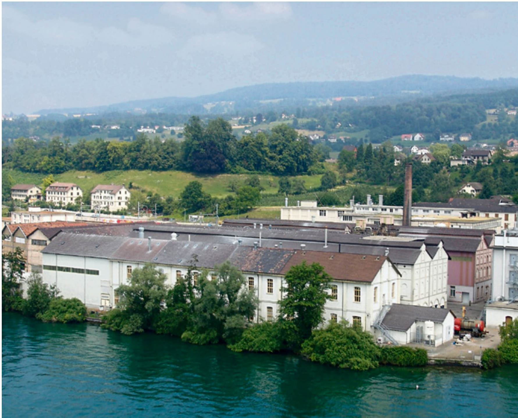
Vor der Uetiker Chemiefabrik hätte ein Steg für die Bevölkerung gebaut werden sollen. Nun wurde das Projekt vom Regierungsrat gestoppt. Bild: zvg
