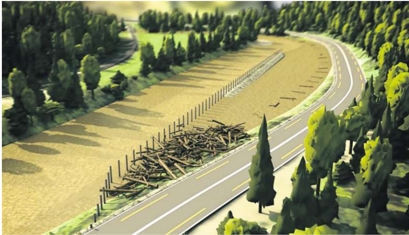
Der seiliche Rechen fängt das Schwemmholz auf, damit es kein Unheil anrichtet. Die Sihl wird dabei nicht gestaut.
