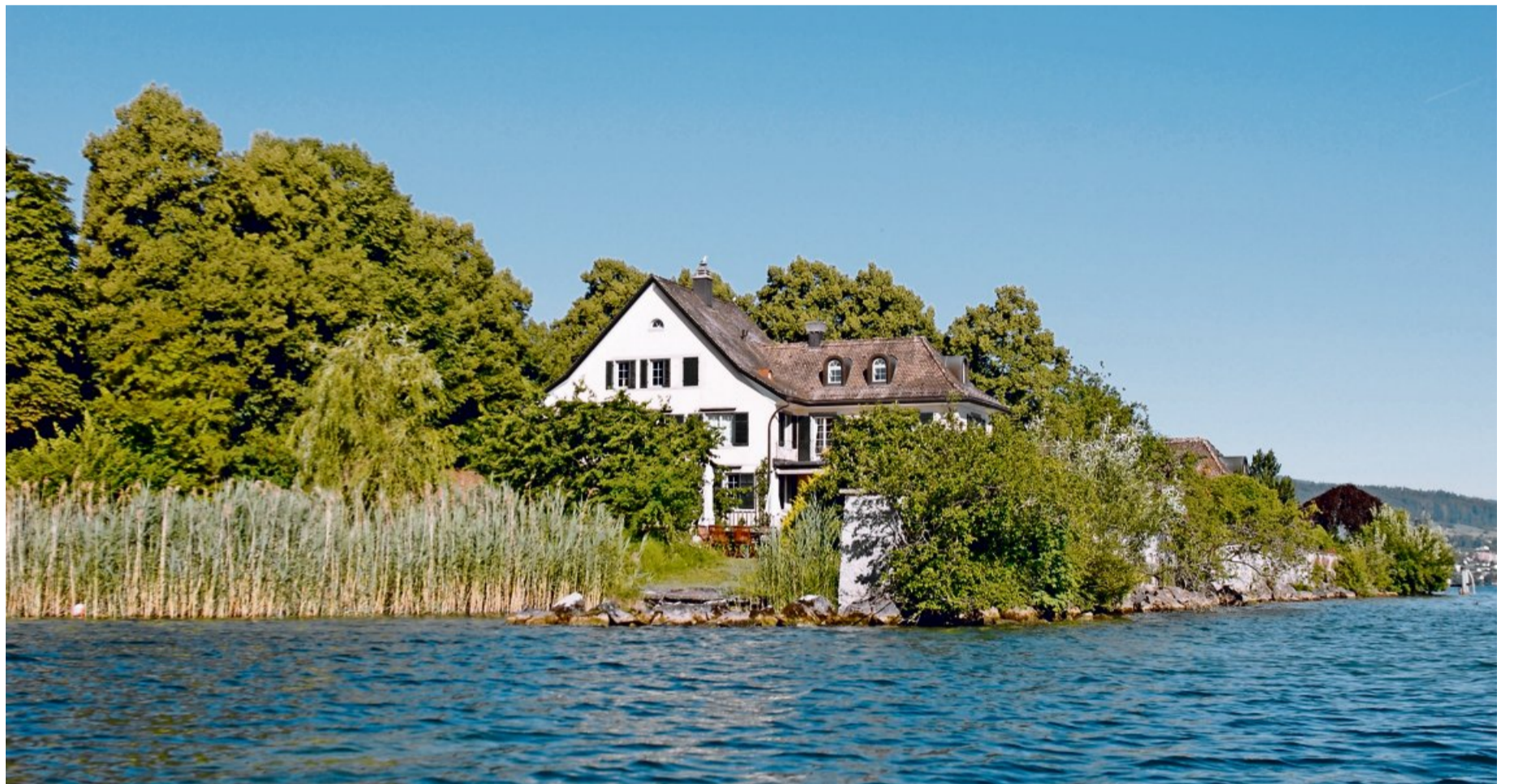
Alte Häuser in Gefahr: Der Heimatschutz befürchtet, dass an den Ufern des Zürichsees künftig verdichtet gebaut wird und auch geschützte Häuser abgebrochen werden.
